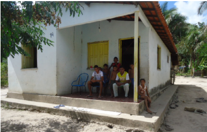
Figura 13 – Residência na Chapada Limpa
