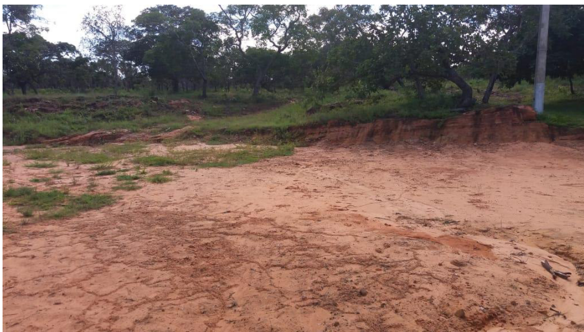
Imagem 1: Assoreamento provocado por desmatamento em área de APP.
